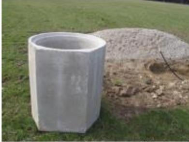
Um den so gesetzten Betonring wird nun der abgeschobene Bereich mit lehmigem Wegekies aufgeschüttet. In diesen Ring kommt die eigentliche Tränke, wobei innerhalb des Rings soweit mit Kies aufgefüllt wird, dass der Rand der eingesetzten Mörtelwanne etwa 10 – 15 cm unterhalb liegt. Die Durchmesser von Betonring und Mörtelwanne sind so zu wählen, dass zwischen beiden ein Abstand von etwa 10 cm verbleibt. Dadurch können abgescheuerte
