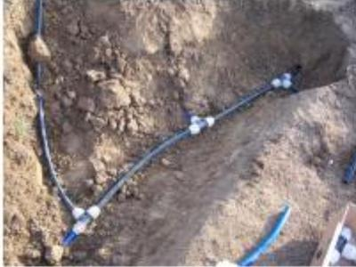
Im geplanten Tränkestandort wird der Pflug aus der Erde gehoben, der Schlauch bei einer freien Länge von etwa einem halben Meter abgeschnitten und mit einem Absperrhahn versehen, um hier die Tränke anschließen zu können. Eine Verlegetiefe von 40 bis 50 cm ist ausreichend. Bei anhaltender Frostgefahr ist das Wasser aus den Leitungen abzulassen. Wenn es das Gelände erlaubt, kann an der tiefsten Stelle der Leitung ein Betonschacht gesetzt werden, in welchem sich ein Ablasshahn
