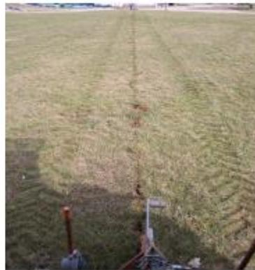
In der Regel werden  $\frac{3}{4}$  bis 1 Zoll-Leitungen verwendet. Werden Leitungslängen von mehr als 1 km erreicht, wird ein deutlicher Druckabfall bemerkbar, hier wäre die Verwendung von 1 Zoll-Leitungen angebracht. Bei normaler Bodenfeuchte geht der Einzug je nach Gerät mit Schrittgeschwindigkeit vonstatten. Die Narbenschäden sind dabei sehr gering (Bild 7).
